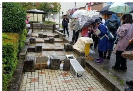
画面右、水路に設置されているのがピコ水力発電装置
