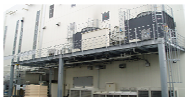
トナー排水処理システム
