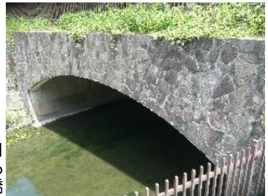
古木津川に架かる孫橋
