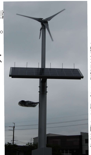
←駐車場に設置してある風力・太陽発電機
